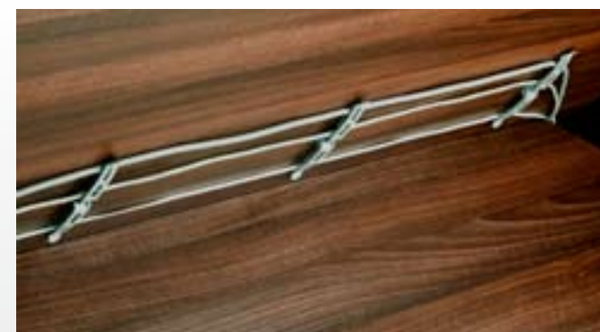
Káblové príchytky zabezpečujú praktické vedenie káblov pod pracovnou doskou
